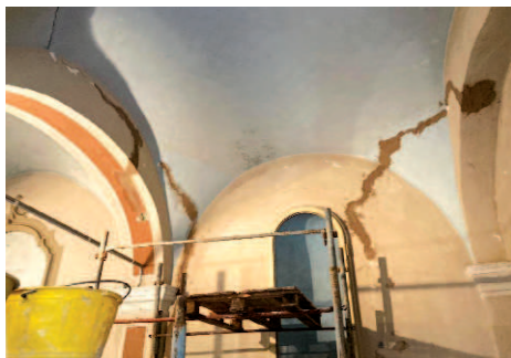
Una istantanea durante i lavori.
