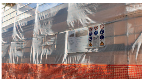
Il ponteggio di copertura e di servizio per i lavori in via di ultimazione della nuova sede in via Teofilo Rossi.
