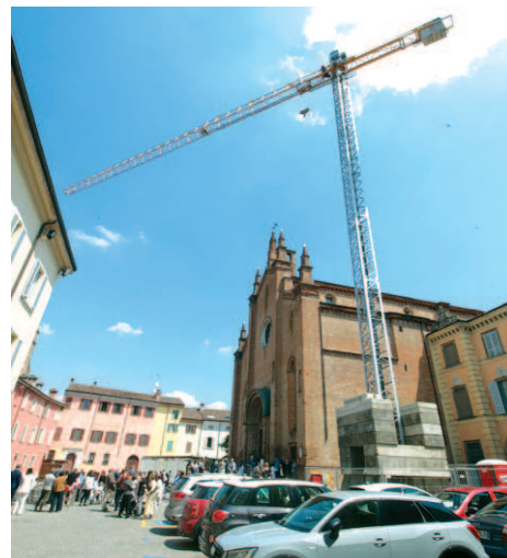
L'imponente gru posizionata a lato della Collegiata, necessaria ai lavori sul tetto.
