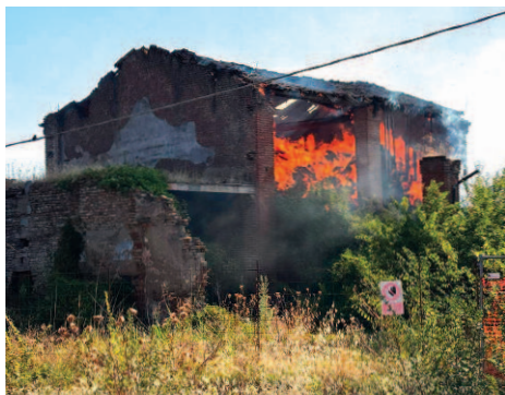
L'incendio alla cascina diroccata che ingloba il sacello della Madonna delle Cinque Strade.
