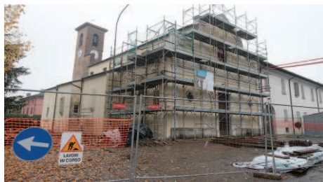
Il vasto cantiere intorno alla chiesa di Baseligaduce.
